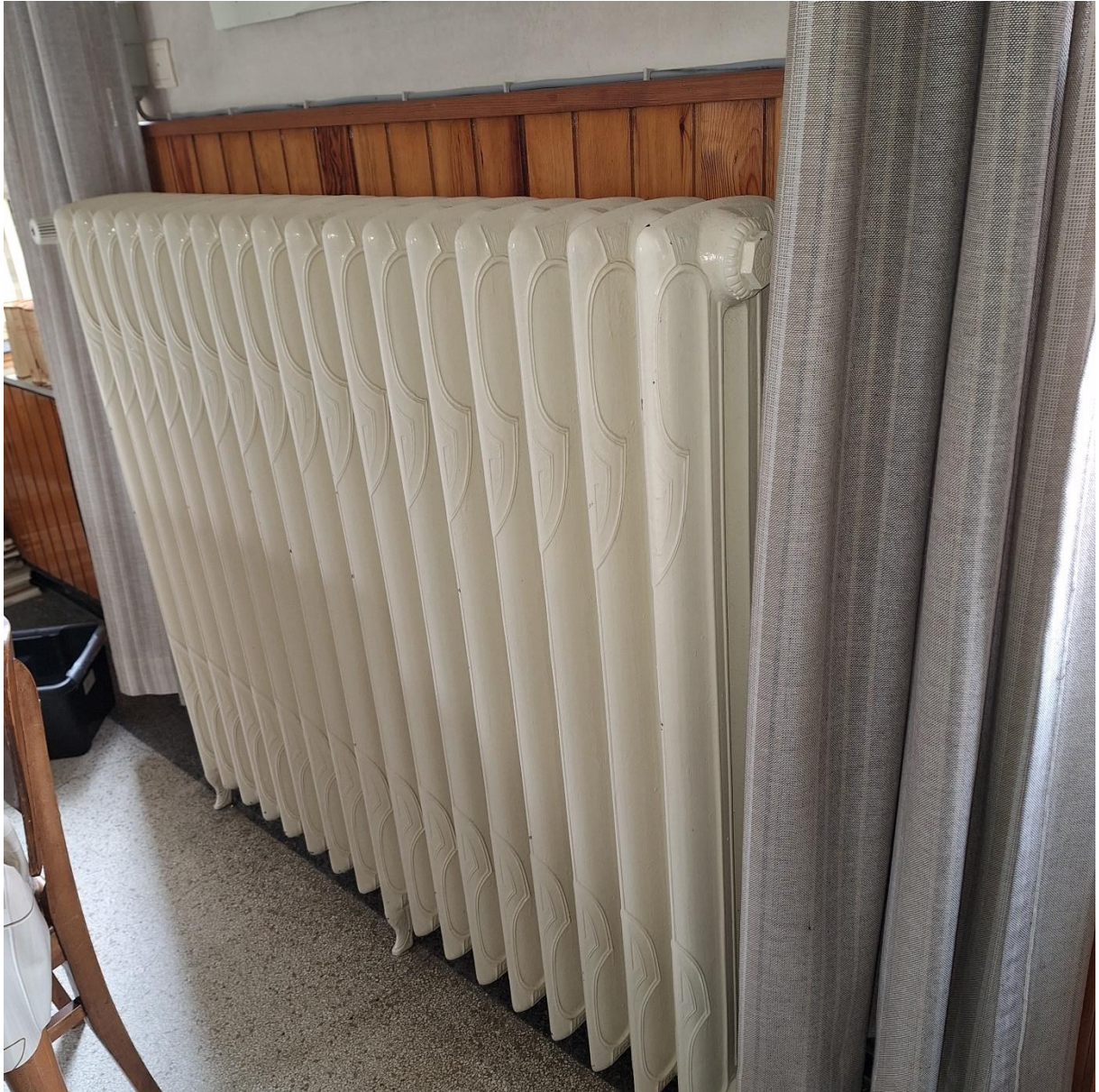
Oorspronkelijke gietijzeren radiator
